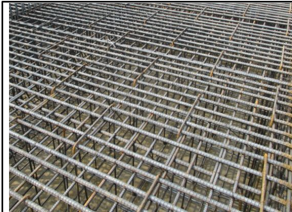
P3 기초 시공 상태
