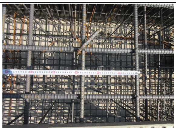
P9 기초 철근 배근 간격
