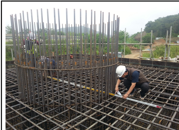
P7 기초 시공 상태 검측
