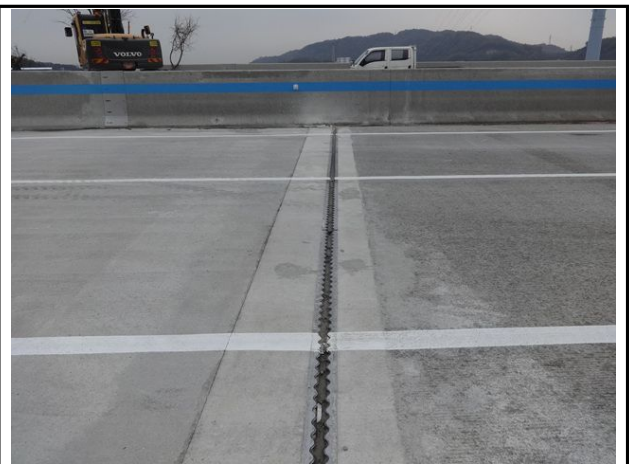
신축이음 A2 전경
