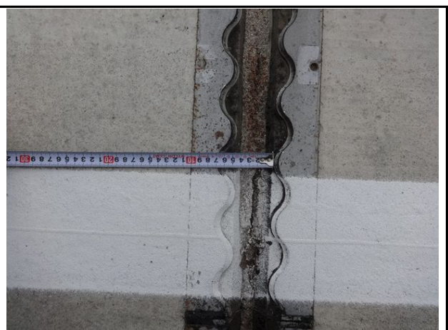
신축이음 P7 유간 측정
