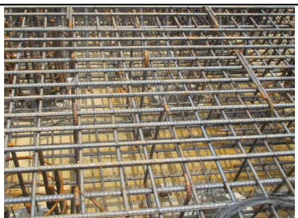
P7 기초 철근 조립 상태
