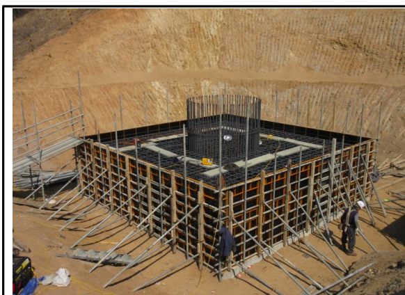
P9 기초 시공 상태
