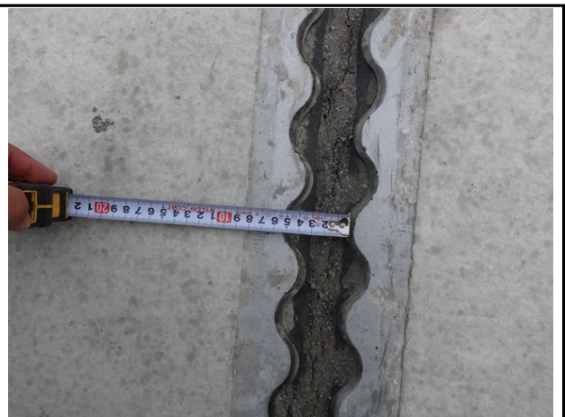
신축이음 A2 유간 측정
