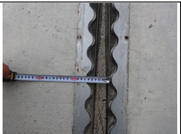
신축이음 P2 유간 측정
