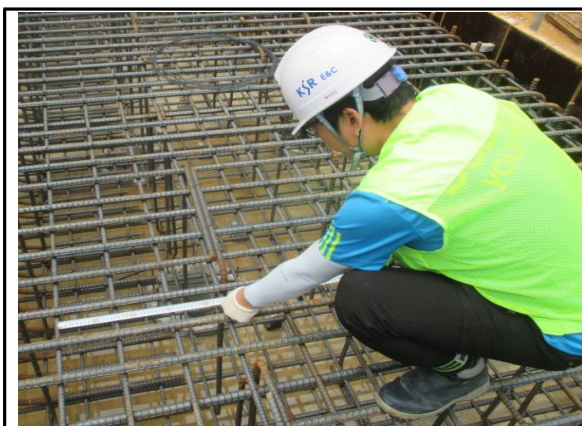
P7 기초 철근 배근 간격 측정
