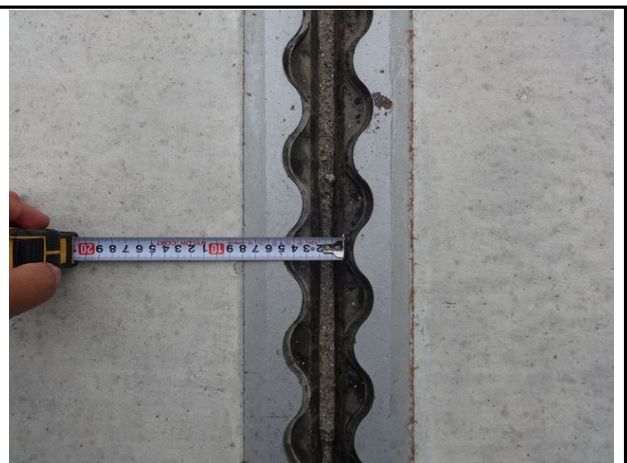
신축이음 P6 유간 측정
