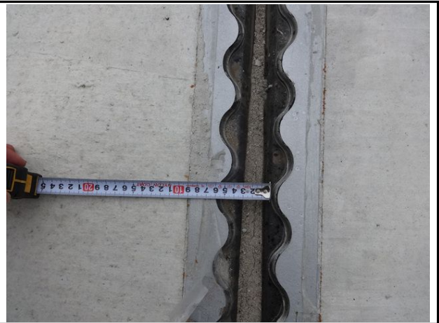
신축이음 P4 유간 측정
