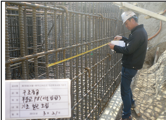
P8 기초 철근 조립 상태
