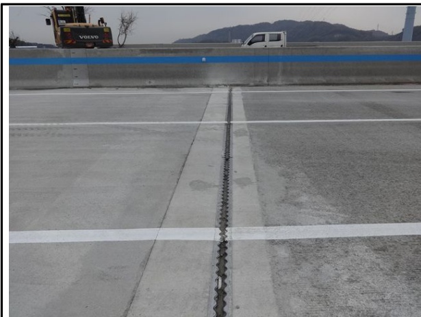
신축이음 A2 전경
