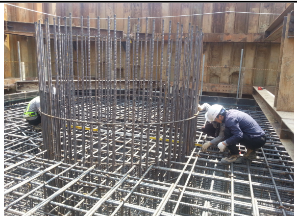
P3 기초 시공 상태 검측
