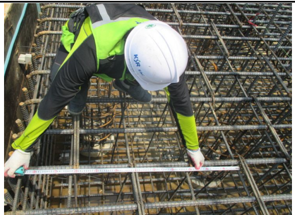
P7 기초 철근 배근 간격 측정
